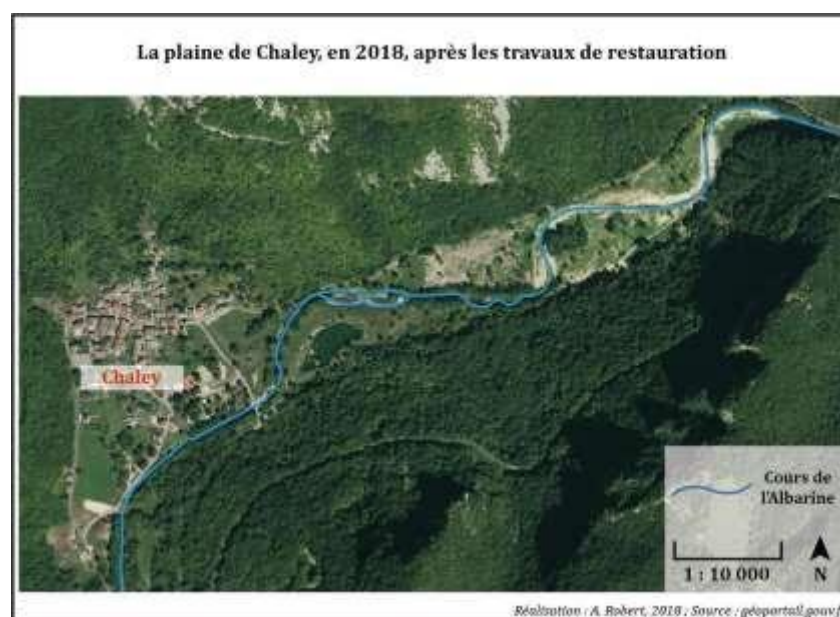
Figure 10 : Chaley après les travaux de restauration.
