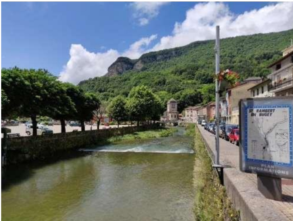
Photo 5 : Les quais de Saint-Rambert.
