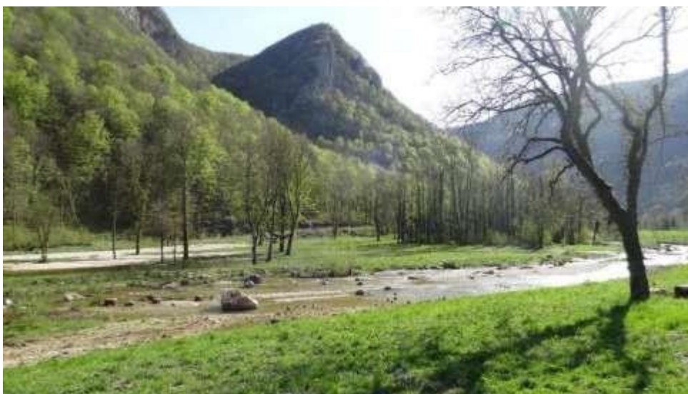
Photo 12 : Plaine de Chaley après les travaux : le lit n'est plus incisé
