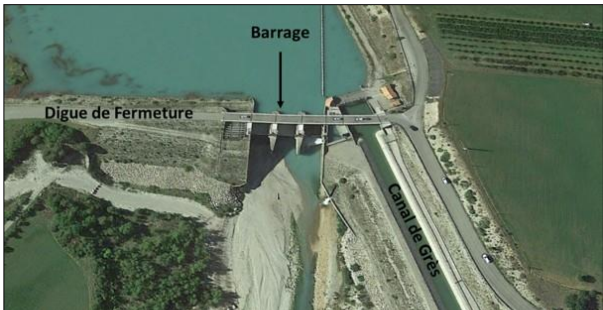
Figure 4 : Photographie aérienne du barrage de Saint-Sauveur et du chenal de Grès (source : Google Earth)
