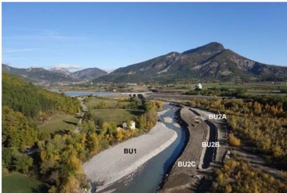
Figure 9. Recharge sédimentaire artificielle en aval du barrage de Saint-Sauveur réalisée fin 2016, avec dénomination des unités de remblais (© EDF)
